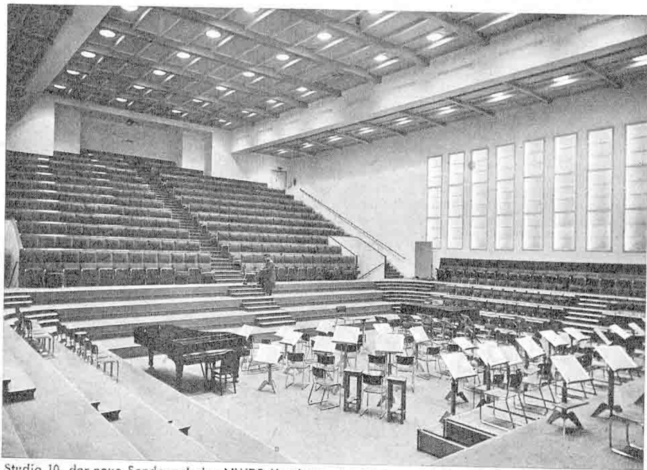
Studio 10, der neue Sendesaal des NWDR Hamburg. Im Hintergrund die schallschluckende Bestuhlung
